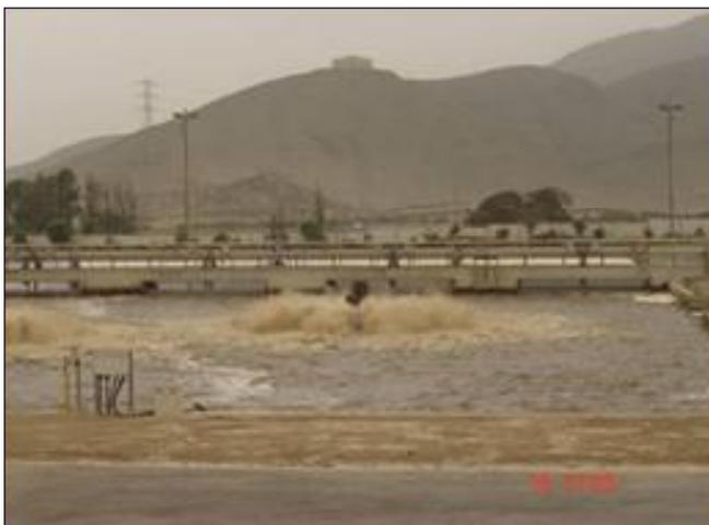
**Foto 11 - Planta de lodos activados de Puente Piedra**
